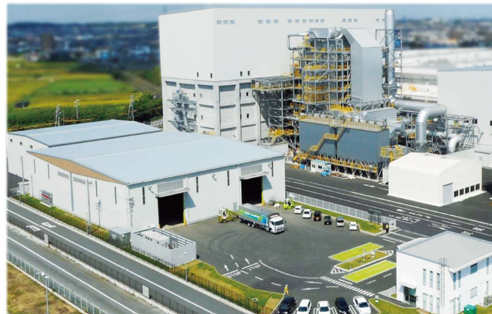
CEPO半田バイオマス発電所 (2019年10月稼働)
