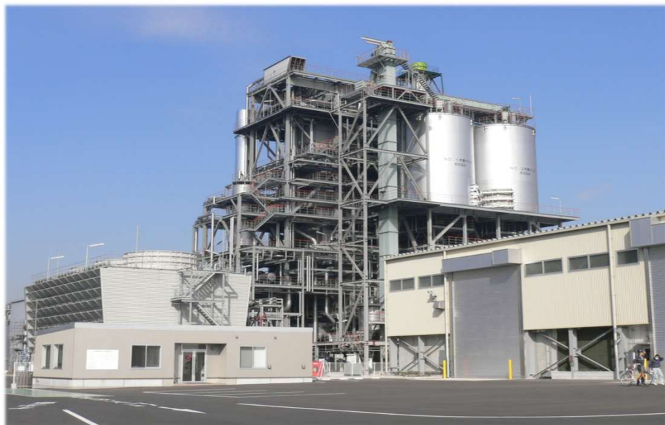
川崎バイオマス発電所 (2011年2月稼働)
